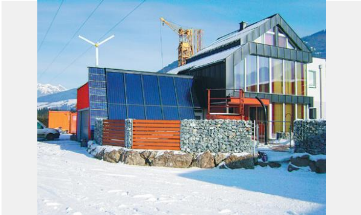
Windrad, Photovoltaik-Anlage, thermische Solaranlage: Das Besondere an dem Haus sei, dass die „Gratis-Energie von Sonne und Wind“ genutzt werde, erklärt Fuchs. Die Solaranlage etwa brachte 2009 einen Ertrag von 9674 Kilowattstunden, das entspräche 1000 Liter Öl, so der Grün-Politiker aus dem Pongau.
